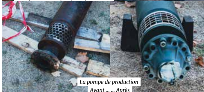
Le 14 septembre au Parc de l'Europe : changement de la pompe de production
