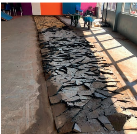
Réfection du sol du préau Rochopt grand bâtiment.
