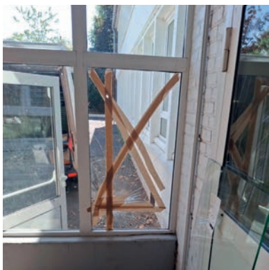
Remplacement de 18 vitrages dans les différents groupes scolaires.
