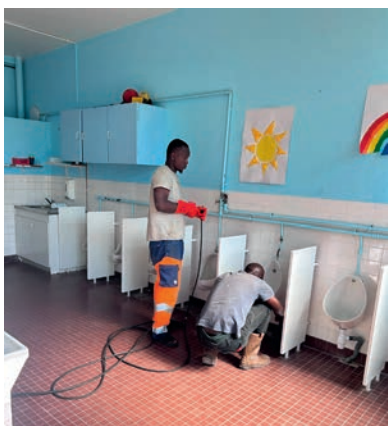
Curage des sanitaires des écoles.
